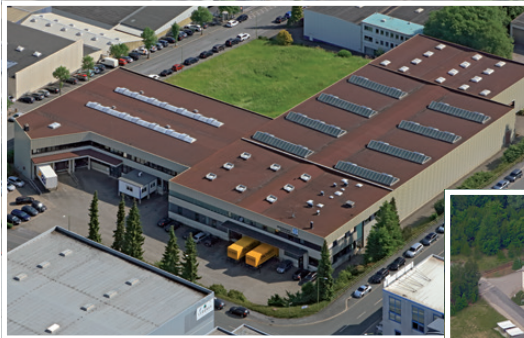
Weichselstraße 9-11, 58256 Ennepetal Logistikzentrum
