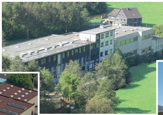
Heilenbecker Straße 191-205, 58256 Ennepetal Hauptverwaltung
