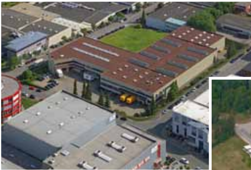
Weichselstraße 9-11, 58256 Ennepetal Logistikzentrum
