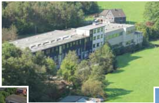
Heilenbecker Straße 191-205, 58256 Ennepetal Hauptverwaltung
