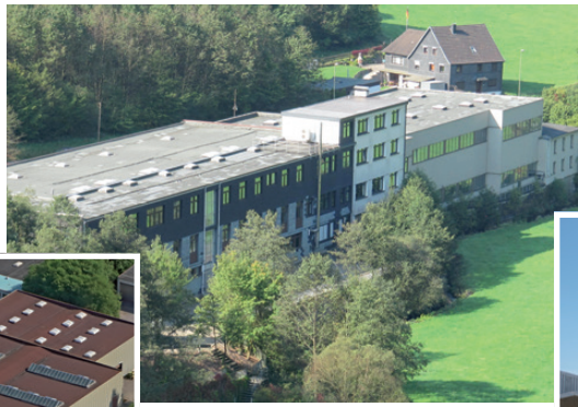
Heilenbecker Straße 191-205, 58256 Ennepetal Hauptverwaltung
