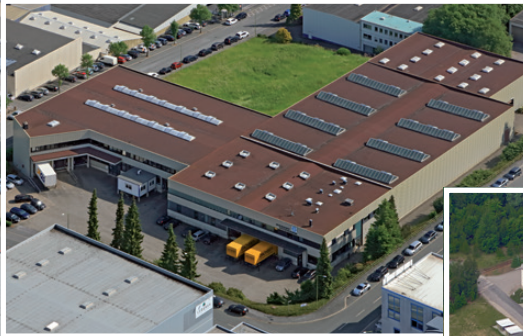
Weichselstraße 9-11, 58256 Ennepetal Logistikzentrum
